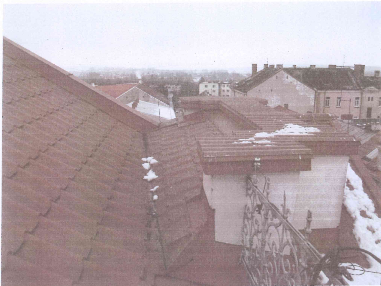
Foto. 6. Dach – elementy instalacji odgromowej.
