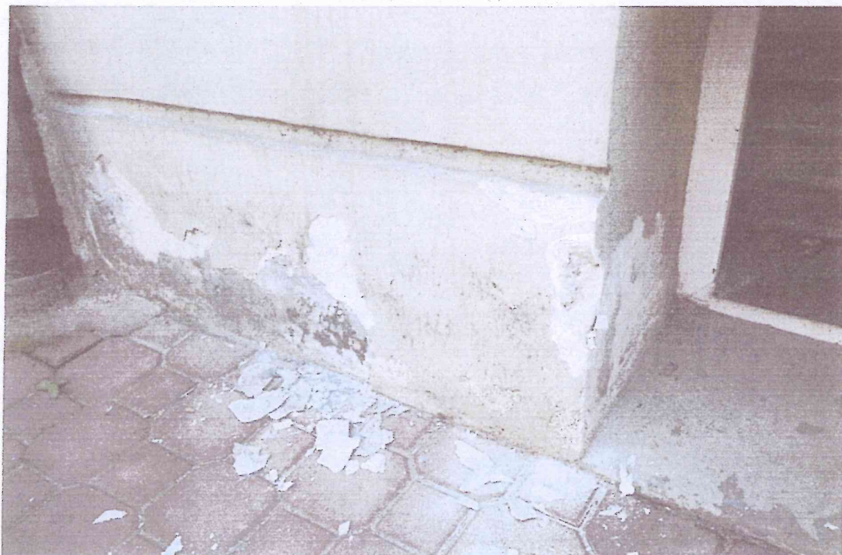
Fot. 3 Fragment niszczonego cokołu. Zaznaczono miejsce pobrania próbki H.
