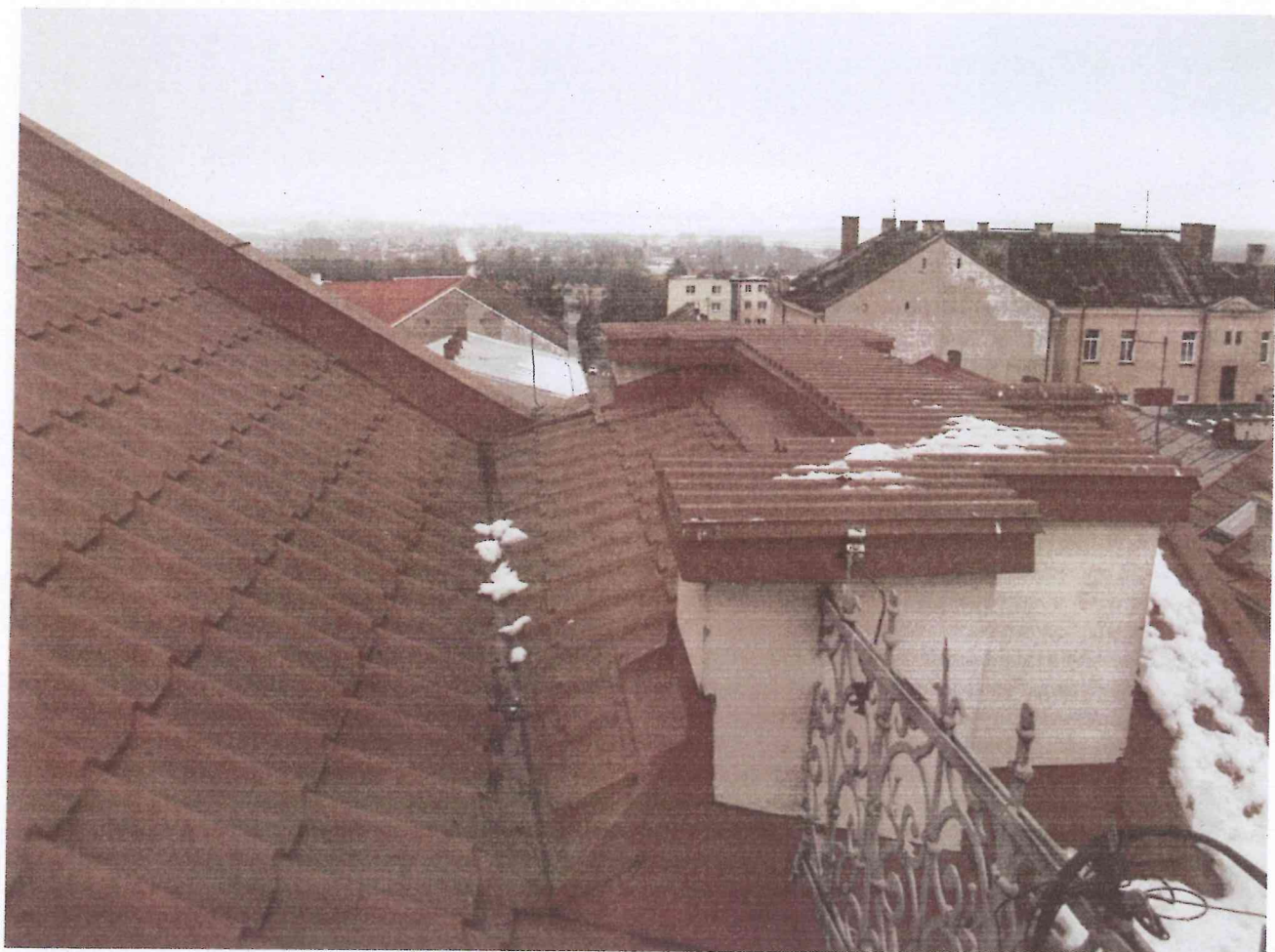
Foto. 6. Dach – elementy instalacji odgromowej.
